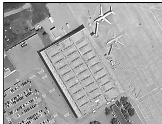
Рис. 17. Термінал А в аеропорту міста Харкова (Fig. 17. Terminal A at the airport of Kharkiv)
