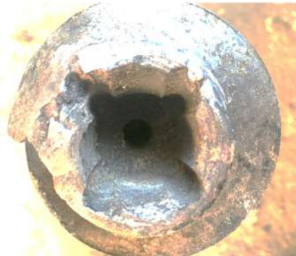
Рис. 7 – Руйнування фігурного з'єднання в шліцьовому шнеку
