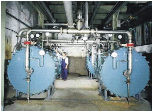
Рис. 2. Спіральні теплообмінники в схемі попередньої обробки зерна.
