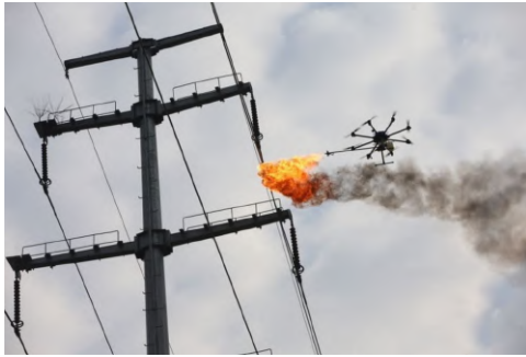
Рис. 4 – Очищення високовольтних мереж за допомогою БПЛА з вогнеметом
