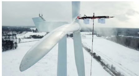
Рис. 5 – Очищення БПЛА лопатей вітроелектрогенераторів
