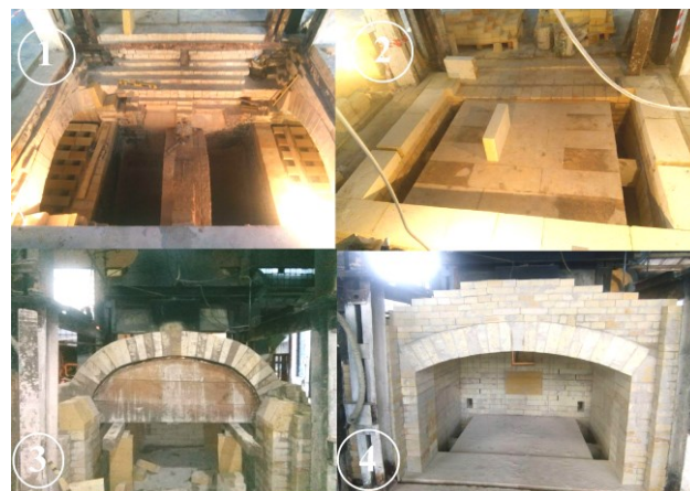
Рис. 5 – Основні етапи капітального ремонту регенераторної печі
