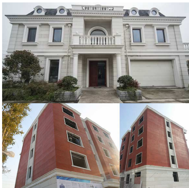
Рис. 13. Маєток (зверху) та п'ятиповерховий будинок (знизу), що надруковані на 3D-принтері компанії WinSun
