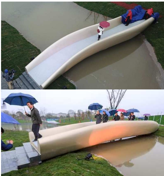
Рис. 7. Найдовший і найважчий надрукований на 3D-принтері пластиковий міст (м. Шанхай, Китай)
