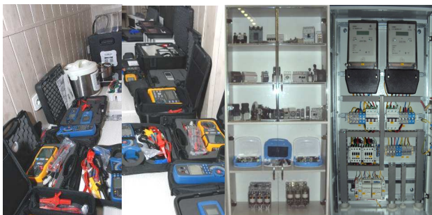
Рис. 4. Частина обладнання, придбаного за кошти гранту AvH
