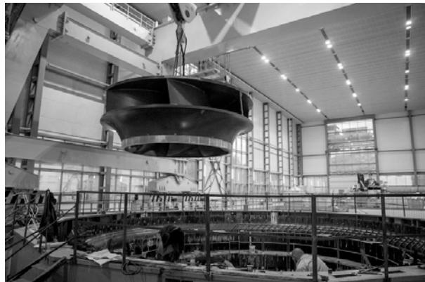
Рис. 2. Монтаж рабочего колеса Днестровской ГАЭС
