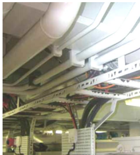
Рис.1 – Фрагмент трассы кабелей на судне
