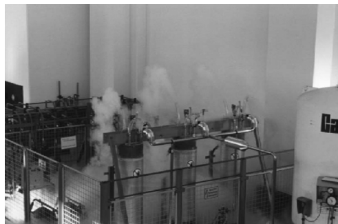
Рис. 2 – Індуктивний обмежувач струму (підстанція Kraftwerk am Lontsch )
