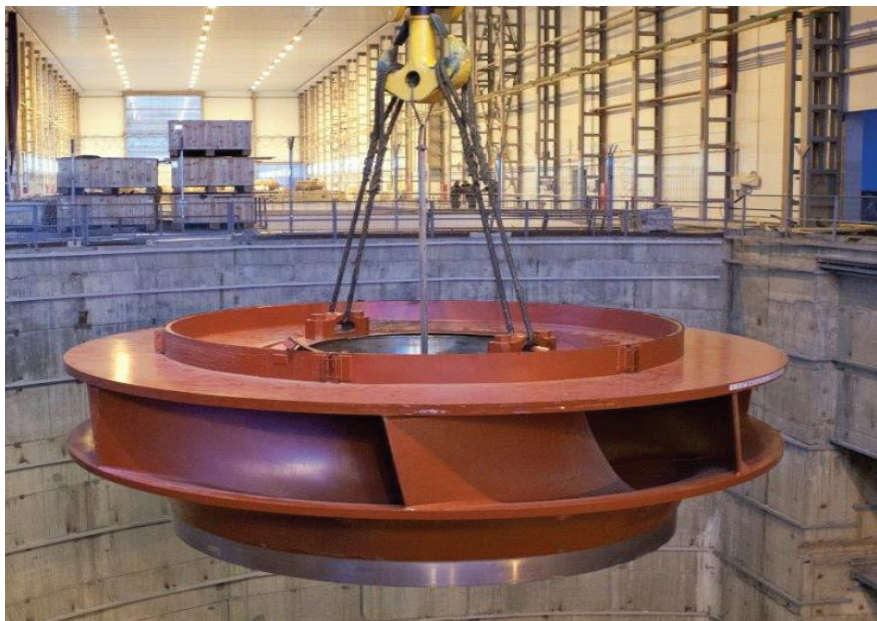
Рис.2 – Рабочее колесо Днестровской ГАЭС
