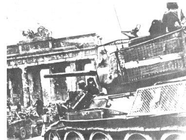
Рис. 4 – Противокумулятивные экраны иницирующего типа на Т-34
