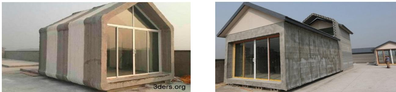
Рис. 1 – Дома в Китае, напечатанные на 3D принтере.
