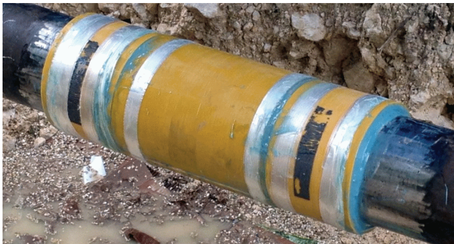
Рисунок 1 – Склопластиковий бандаж, нанесений на трубопровід
