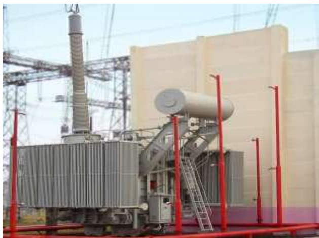
Рис. 1 – Однофазный шунтирующий реактор РОМ – 110000/750
