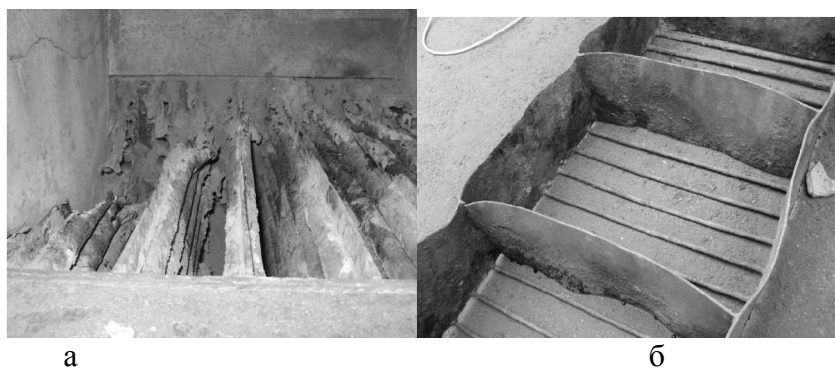
Рис.2. Коррозия а – рекуператора, б – кассеты катализатора из стали 12X18H10T
