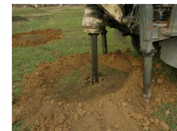
Рис. 1– Скважины под электроды повышенной проводимости растеканию
