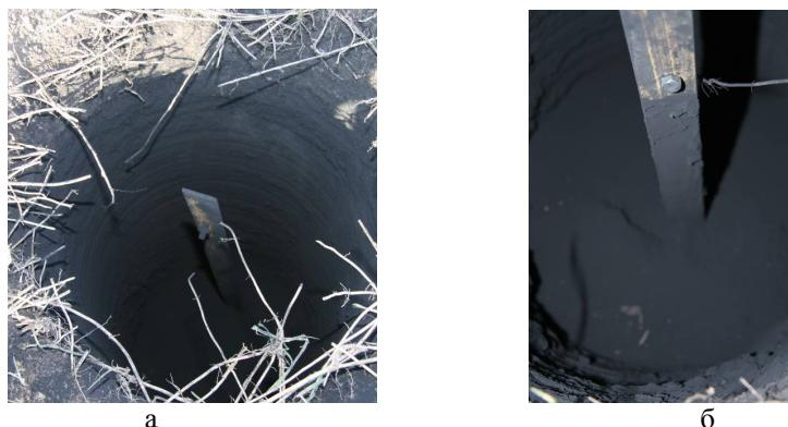
Рис. 2 – Вертикальные электродаы повышенной проводимости растеканию: а – без покрытия; б – с покрытием.
