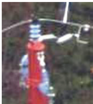
Рисунок 10 – Пробой искрового промежутка УЗАП-0
