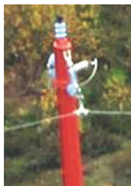
Рисунок 14 – Пробой искрового промежутка УЗАП-К
