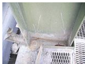
Рис. 4. Узлы сочленения фермы (карманы). Приемная консоль (ОШС черт. 126.00.00.000)
