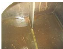
Рис. 5. Вода в полостях базы (ОШС черт. 126.00.00.000)
