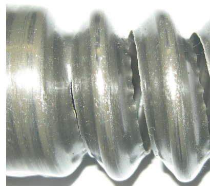
Рис. 21. Фотография трубы с винтовой трещиной
