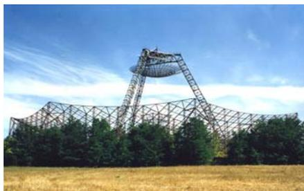
Радар НР с параболической антенной диаметром 100 м
