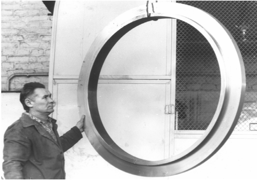
Рис. 6. Жесткое колесо волнового редуктора поворота миксера МП-600АС
