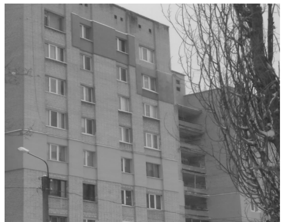
Рисунок 1 – Приклади «точкового» утеплення типових будівель м. Харкова
