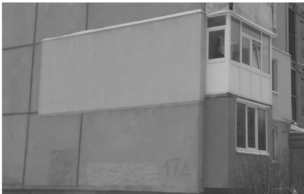
Рисунок 1 – Приклади «точкового» утеплення типових будівель м. Харкова
