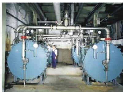
Рисунок 2 – Ширококанальные и спиральные теплообменники в схеме предварительной обработки зерна
