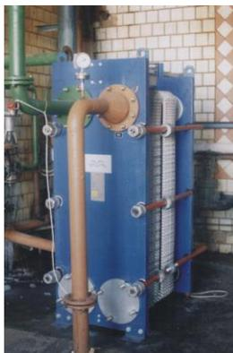
Рисунок 5 – Ширококанальный теплообменник AM20S для охлаждения суслу установленный компанией «Содружество-Т» на спиртзаводе г. Борщив (Тернопольская обл.)
