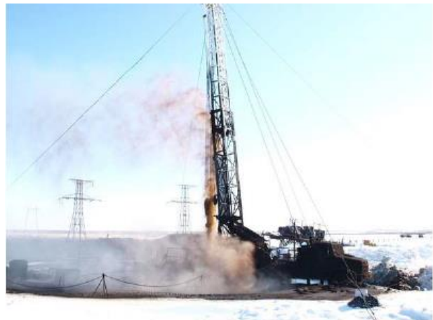
Рис. 3. Відкритий фонтан при капітальному ремонті
