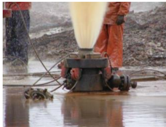
Рис. 2. Монтаж фланця ФРЕК–168x35 на гирлі свердловини № 102 Олишівського ПСГ
