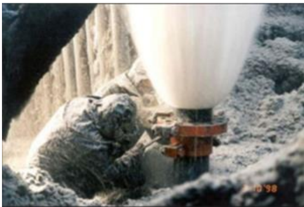
Рис. 1. Монтаж фланця ФР– 245x35 на гирлі свердловини № 324 Карачаганакського ГКР
