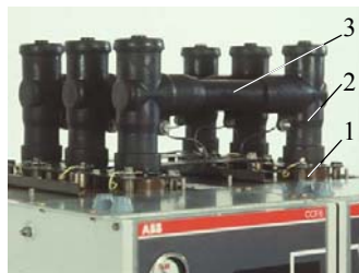
Рис. 25. Прохідні ізолятори (1), адаптери (2) та зовнішні шини (3) на кришках блоків SafePlus
