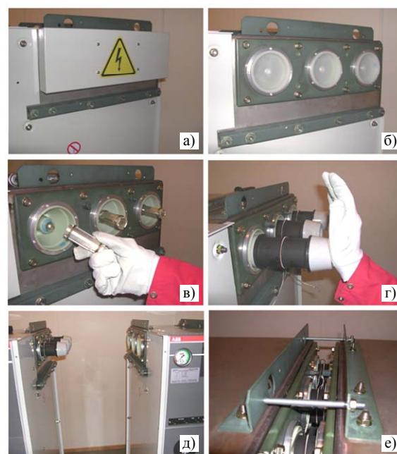
Рис. 23. Етапи з'єднання блоків за допомогою аксесуарів бокового розширення
