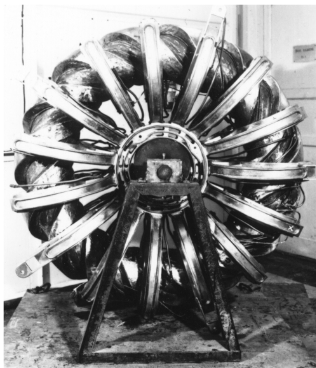
Рис. 12. На винтовую обмотку одеты силовые каркасы
