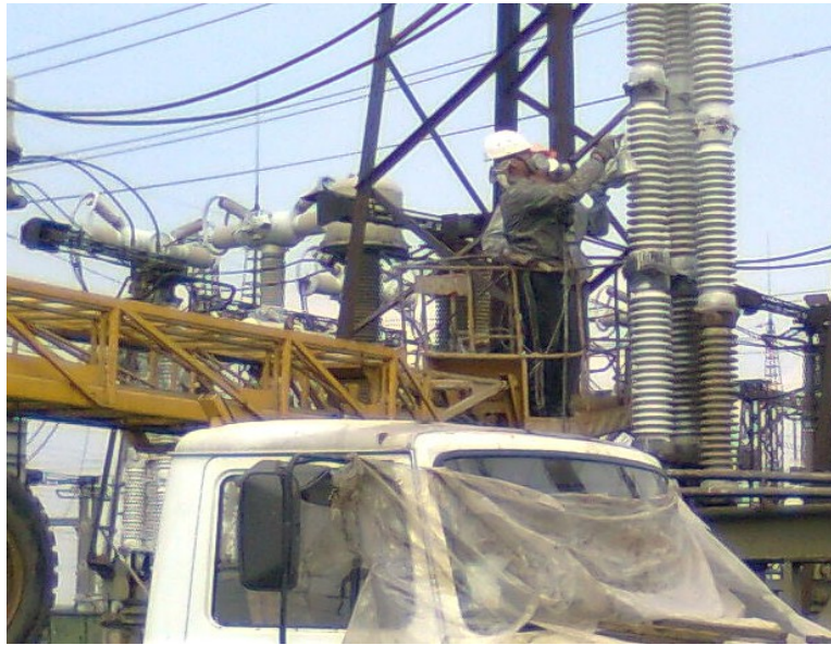
Рис. 4. Нанесення RTV покриття на роз'єднувач ВРП 330 кВ Курахівської ТЕС
