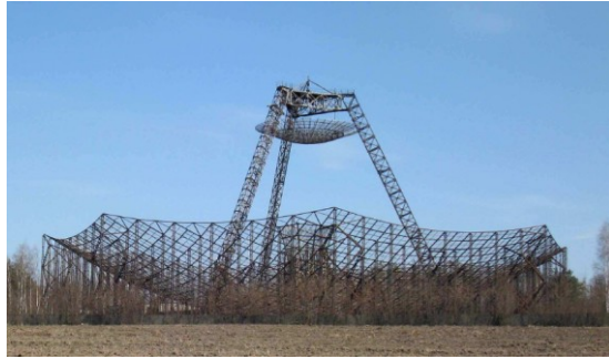
Рис. 6. Радар НР з параболічною антеною діаметром 100 м
