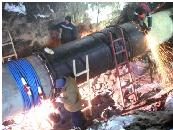
Рис. 9. Ремонтні роботи на магістральному газопроводі ДУ 1200×12 мм «Уренгой-Помари-Ужгород» з використанням розробленої в ІТПМ НАН України технології розмагнічування зварювальних стиків (м. Тернопіль, 2017 р.)
