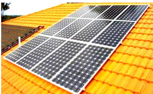
Рис. 12. Внешний вид небольшой жестко закрепленной на крыше жилого дома неподвижной солнечной панели [15]
