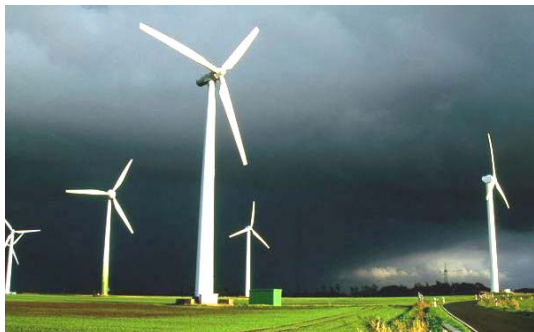
Рис. 1. Общий вид современной горизонтально-осевой трехлопастной ВЭУ установленной мощностью до 250 кВт, размещенной на равнинной прибрежной территории [10]
