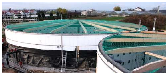
Рис. 23. Общий вид современной биогазовой установки [5]
