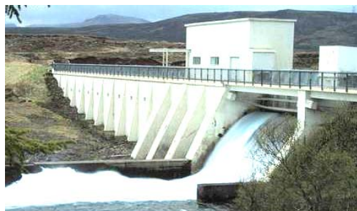
Рис. 28. Общий вид плотины и машинного отделения отечественной МГЭС (2009 г., Украина) [30]
