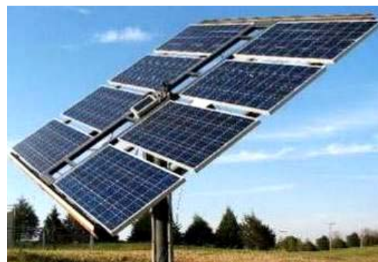
Рис. 13. Внешний вид небольшой подвижной солнечной панели с системой слежения (поворота) «за Солнцем» [15]
