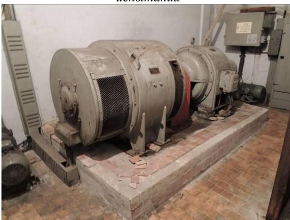
Рис. 4. Двухмашинный агрегат электропитания стенда для разгонных испытаний
