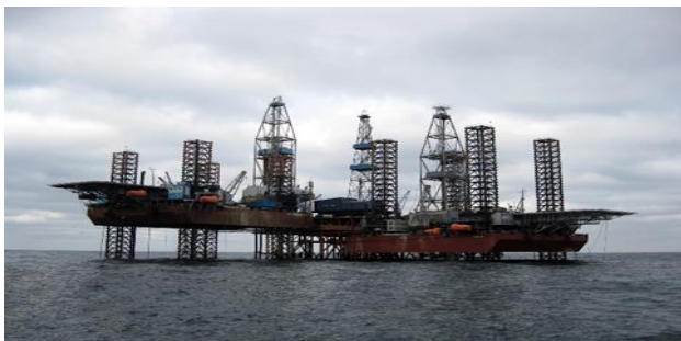
Рис. 3. Самопіднімальна плавуча бурова установка (СПБУ) "Петро Годованець"
